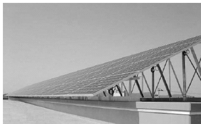
現行において建築基準法の準用工作物として取り扱われている太陽光発電設備のイメージ
